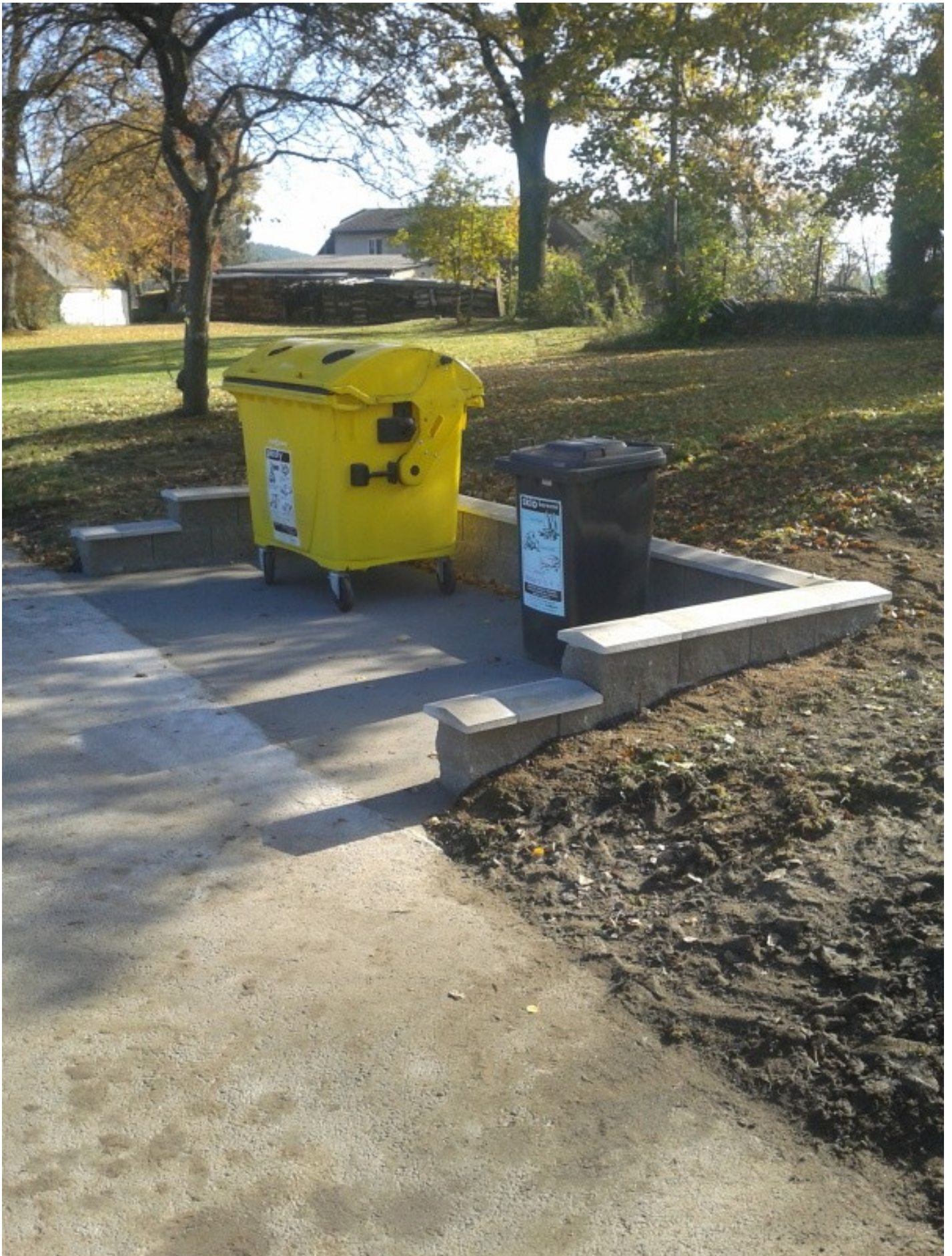
Zastávka Rudolec, stání pro kontejnery Podpořeno z dotace Středočeského kraje v roce 2016
